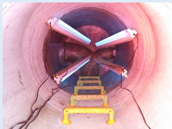
シート硬化状況
