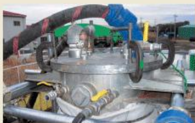
ターヤンマンホールライニング材硬化状況
