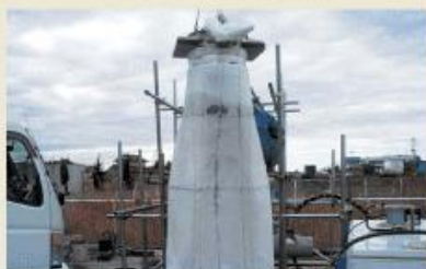
ターヤンマンホールライニング材挿入状況
